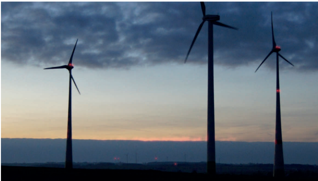
Abb. 18: Windenergieanlagen in der Dämmerung, die Nachtbefeuerung ist bereits erkennbar (Quelle: TU DRESDEN, LACHOR)
