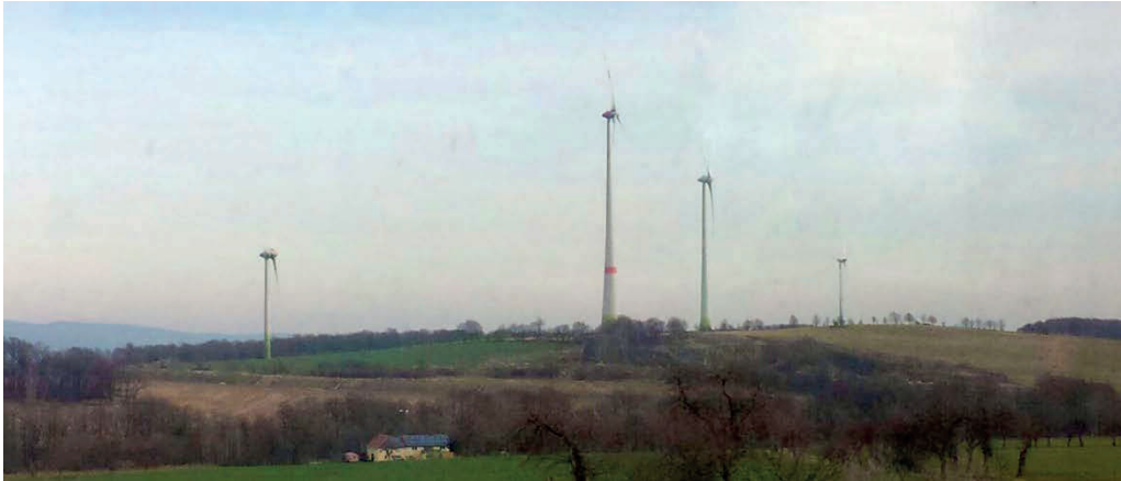
Abb. 19: Windenergieanlagen verschiedener Typen (Quelle: TU DRESDEN, VON GAGERN, 2016)
